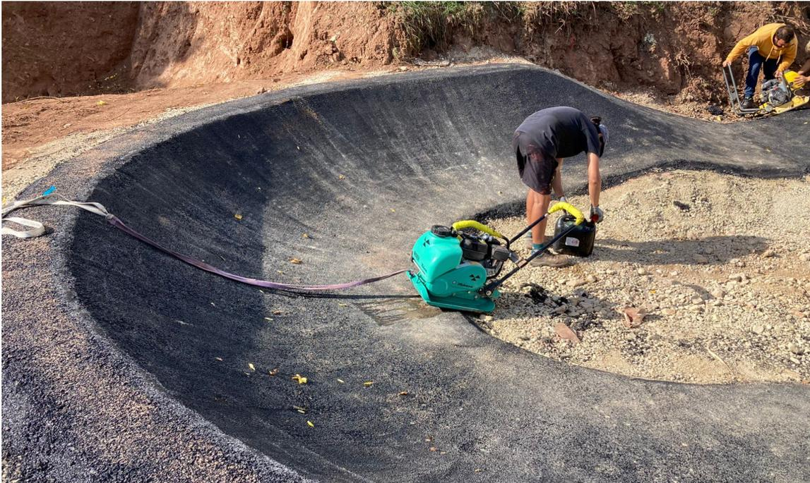
Un grupo de 4 operarios especialistas en extendido de asfaltos irán extendiéndolo en el recorrido de forma manual con la aportación del material mediante maquinaria mini o incluso carretillas, turnándose cuando la superficie extendida supere los 10m<sup>2</sup> con otro grupo de 2 a 3 operarios que irán compactándolo con bandejas vibratorias que en algunos lugares deberán ir colocadas con cuerdas para facilitar el paso por las zonas con mayor inclinación como los peraltes.
